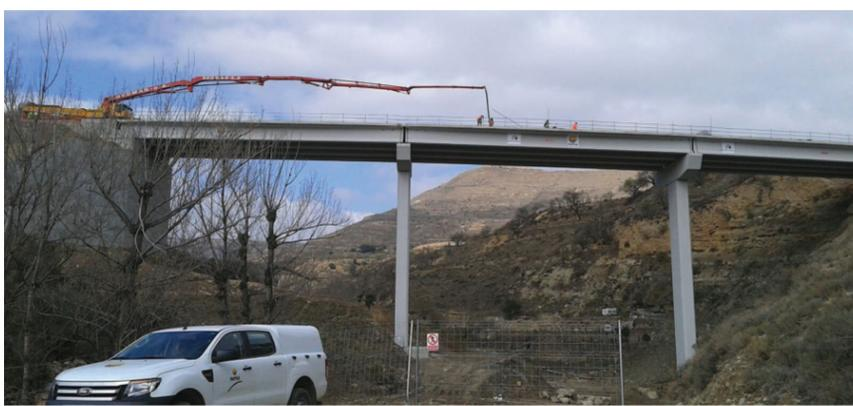
**Trabajos de hormigonado del puente de más de 100 metros de longitud.**
